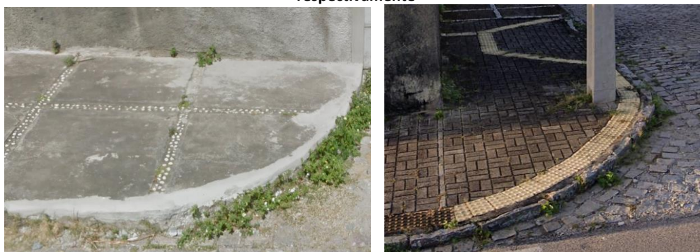
Figura 2: Calçadas externas em cimentado liso com seixos (Rua Apolonio Sousa) e intertravado (Anel viário), respectivamente
