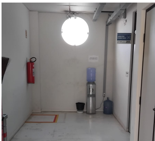
Imagem 08: Parede de acesso ao prolongamento da laje.
